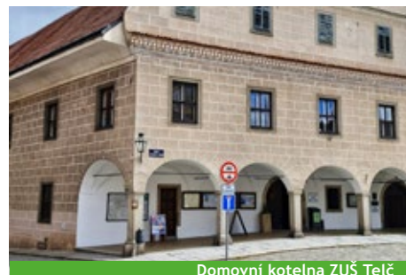
Domovní kotelna ZUŠ Telč
