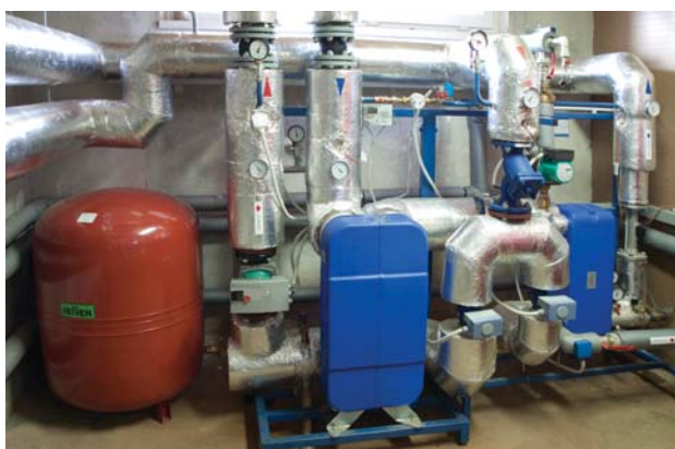
předávací stanice po rekonstrukci
