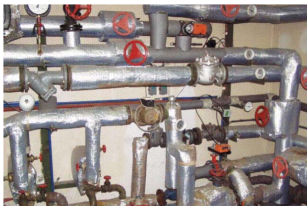
předávací stanice před rekonstrukcí
