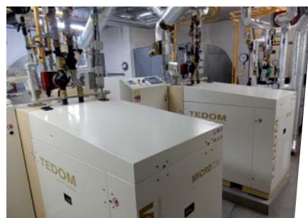
kogenerační jednotky Vodní ráj
