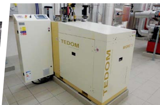
modernizace kotelny Nad Plovárnou - výměna kogenerační jednotky
